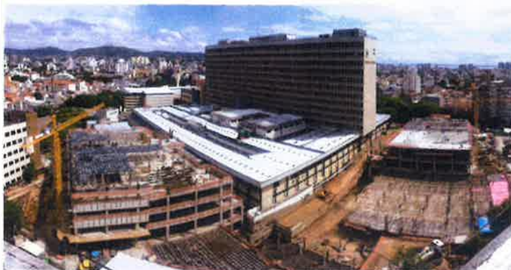
Visão Geral do Canteiro de Obras Dezembro/15
