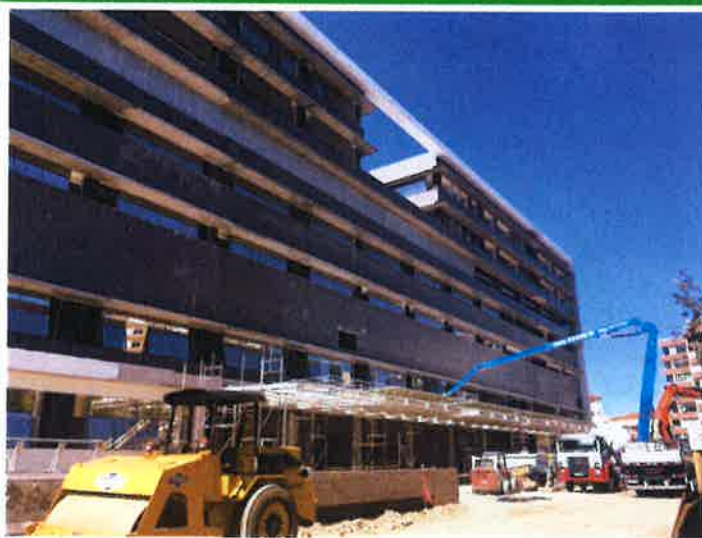
Fachada- Anexo I
