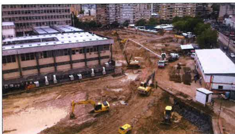
Visão Geral do Canteiro de Obras Dezembro/14
