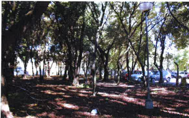
Visão Geral do Canteiro de Obras Maio/14
