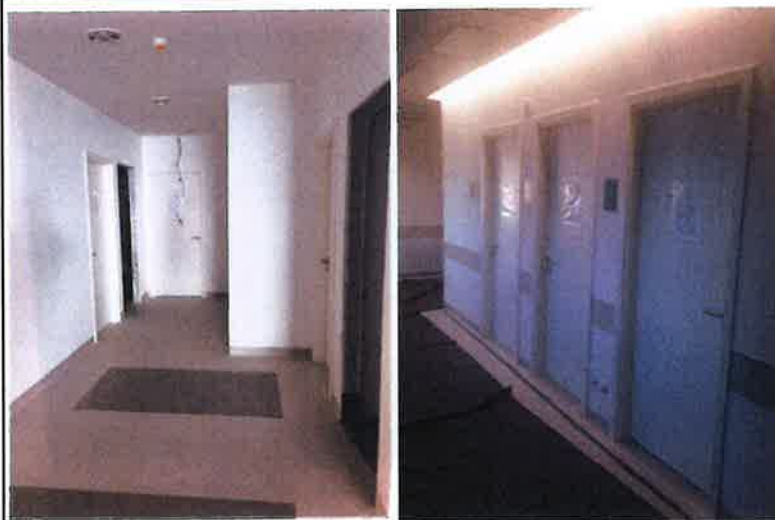
Interior Portas de madeira
