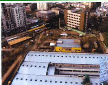
Visão Geral do Canteiro de Obras Agosto/14
