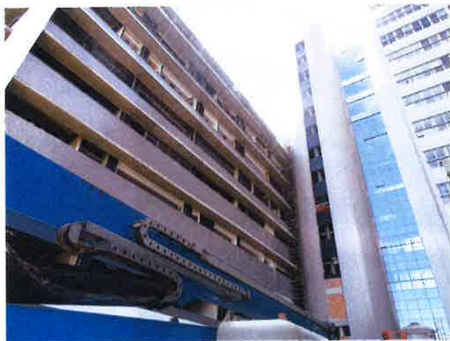
Fachada- Anexo I
