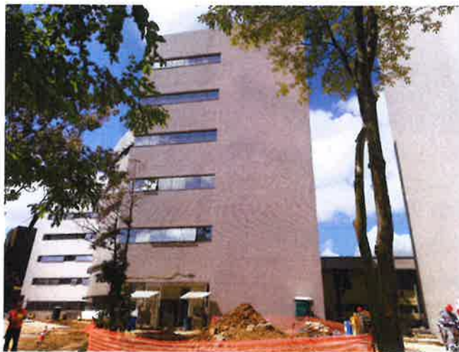
Fachada Esquadrias de alumínio
